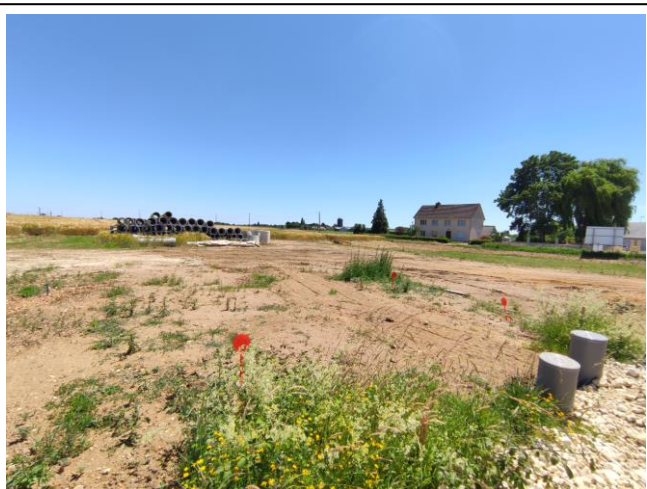
Photographie du site vue depuis le Nord
