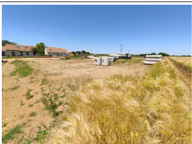
Photographie du site vue depuis le Sud
