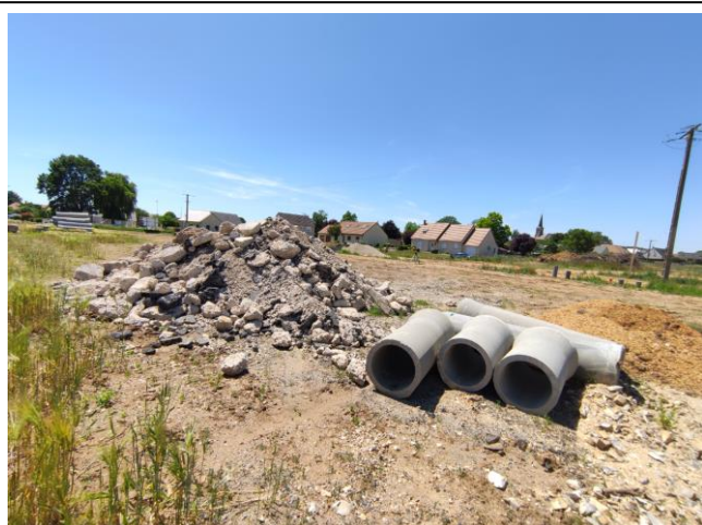
Photographie du site vue depuis le Est
