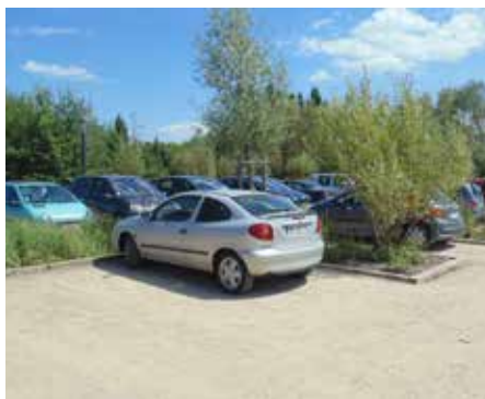
Exemple d'espaces de stationnement en matériaux perméables et poreux
