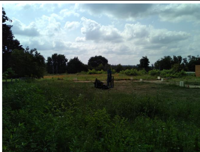
Photographie du site vue depuis le Nord-Est
