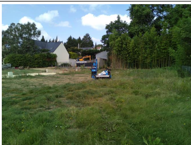
Photographie du site vue depuis le Sud-Est
