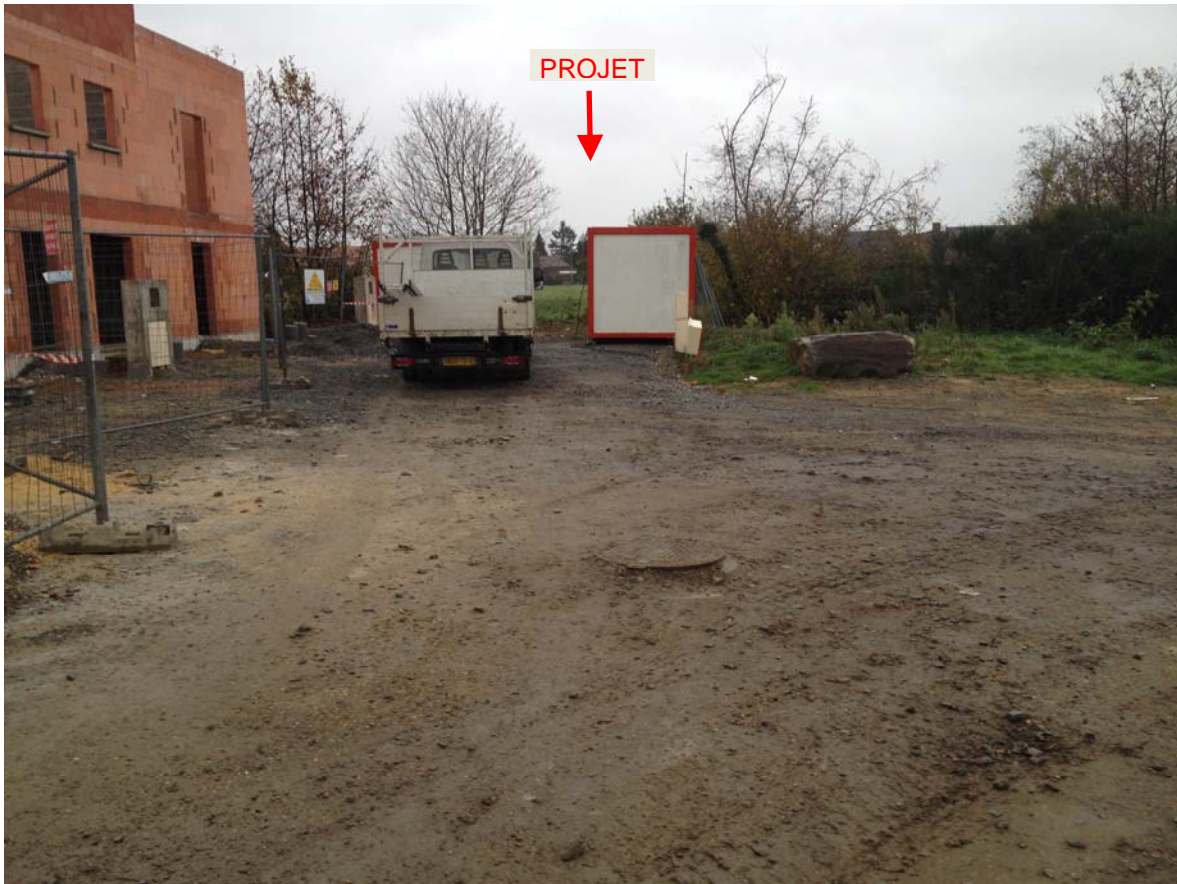
Vue sur la limite Ouest depuis la rue du Grand Hermitage en construction qui donnera accès au lotissement
